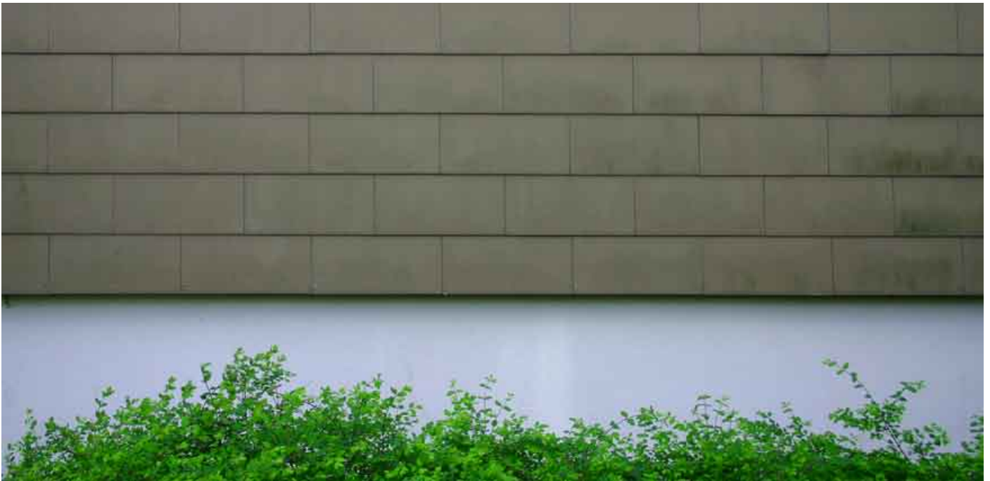
Hochhaus mit graubrauner Verkleidung
